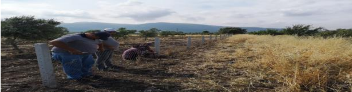
Dualar Mahallesi Kurtyeri Mevkiindeki Arazi Kenarlarına Çit Çekilmesi İşi
