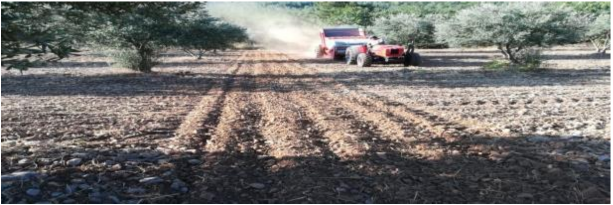
Şekil 85- Sarıkaya Mahallesi 12 Parselde Kayıtlı Şahsa Ait Arazide Taş Toplama Çalışması
