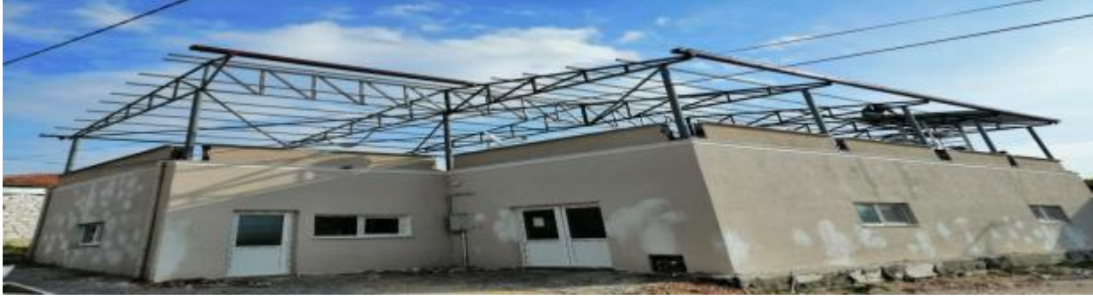
- AKÇAAVLU MAHALLESİ ÇOK AMAÇLI SALON ÇATI YAPIM İŞİ
