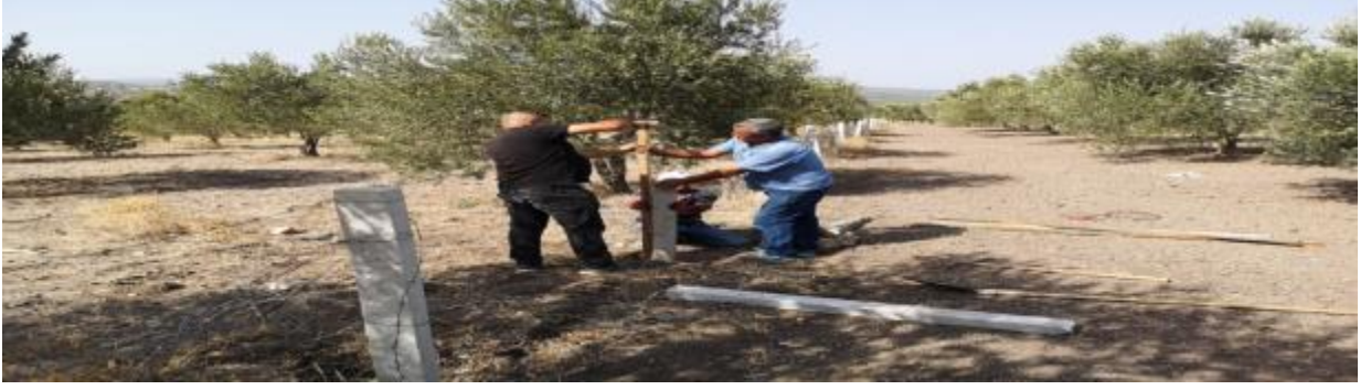
Şekil 102- Dualar Mahallesi Kurtyeri Mevkiindeki Arazide Çit Tamiratı Çalışmaları
