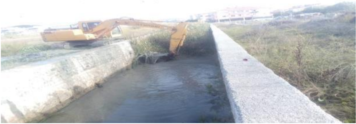
-İSTASYON MAHALLESİ DERE TEMİZLİK ÇALIŞMASI-
