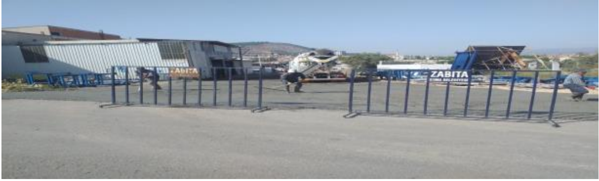
-HÜRRİYET MAHALLESİ EKİN SOKAK (SANAYİ SİTESİ) BETON YOL YAPIMI-
