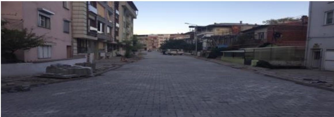
HAMİDİYE MAHALLESİ MÜNEVVER SOKAK TAŞ DÖŞEME ÇALIŞMASI
