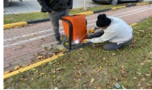
Görüntü 23. Yeni Kurulan Park Tipi Çöp Sepeti Montaj Çalışmalarından Bazı Görüntüler
