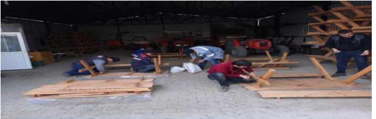
Şekil 33. Muhtarlık İşleri Müdürlüğü Şantiyesinde Mesire Alanına Piknik Masası Montajı
