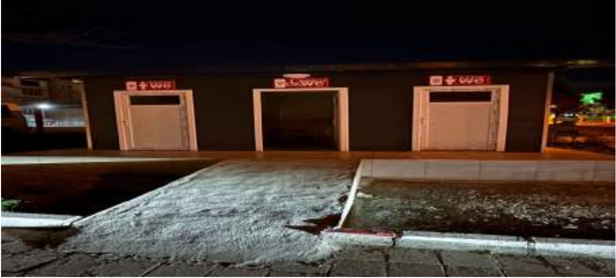
CUMHURİYET MAHALLESİ WC YAPIM İŞİ
