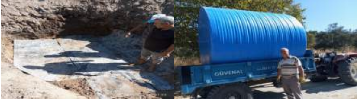
Boncuklu Mahallesi Su Deposu Yeri Zemin Hazırlığı
