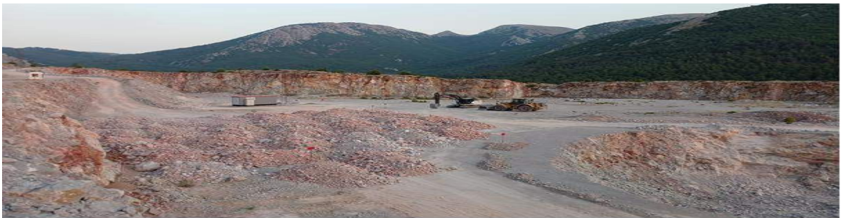
TAŞ OCAĞI ÇEŞİTLİ EBATLARDA AGREGA ÜRETİM ÇALIŞMASI
