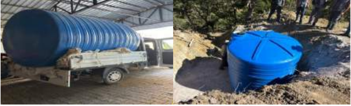
Kaplan Mahallesi Su Deposu Monte Çalışmalarından Görüntüler
