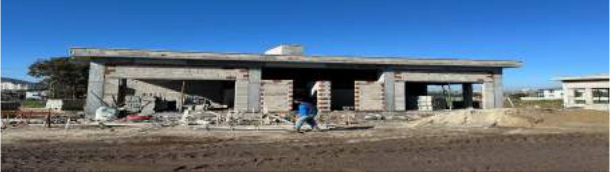
SOMA BELEDİYESİ GALERİCİLER SİTESİ 1. ETAP YAPIM İŞİ
