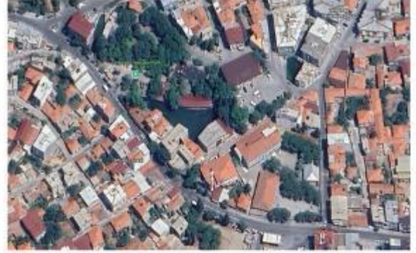
2.T.ALIP MAH. MERKEZ PARK HAVUZU SU KAYNAK HAVUZ ÇIKIŞI VE KÜÇÜK HAVUZ SU KAYNAKLARI
