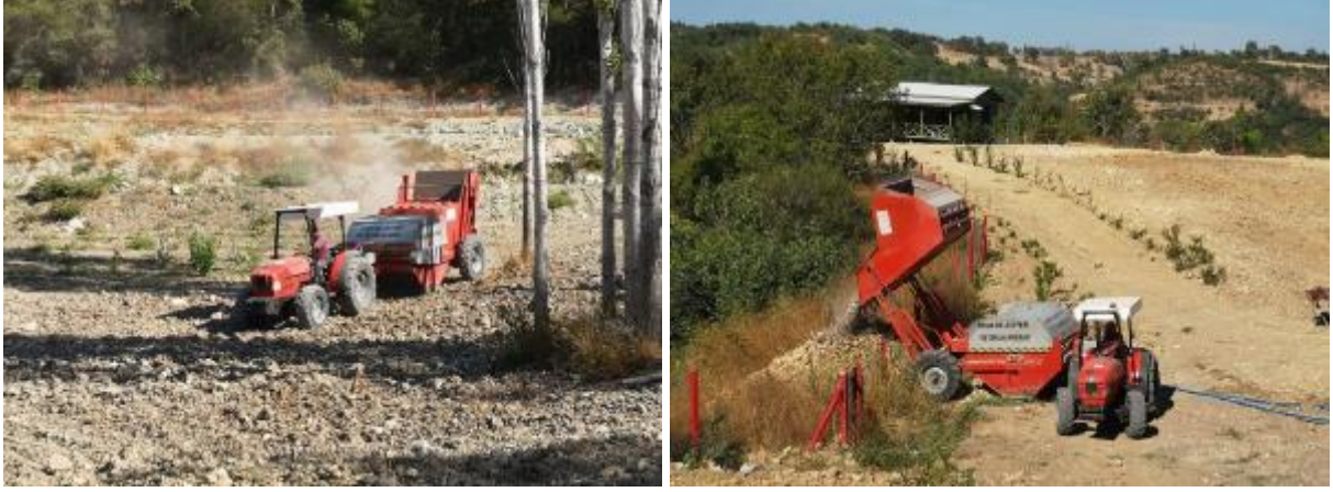
Şekil 45 ve 46- Koyundere Mahallesinde Kayıtlı Şahsa Ait Arazide Taş Toplama Çalışmaları
