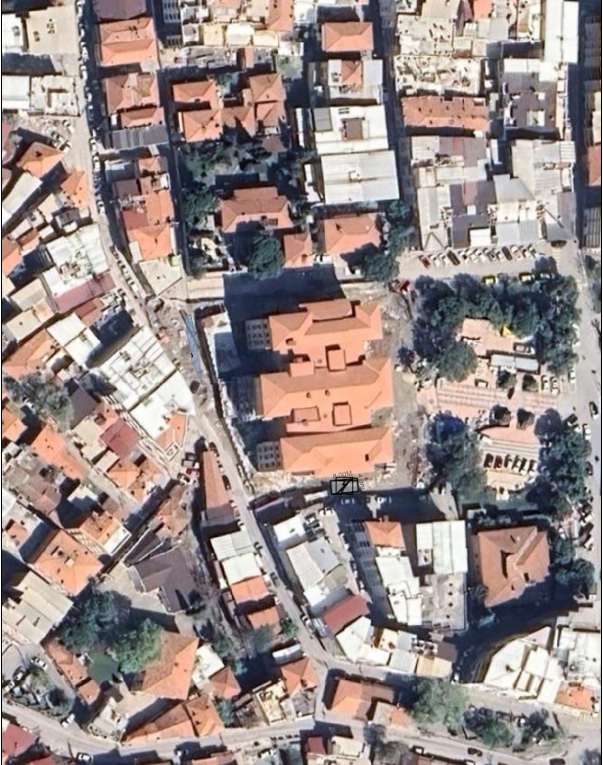
-Trafo ve Park Alanının Uydu Görüntüsündeki Konumu-
